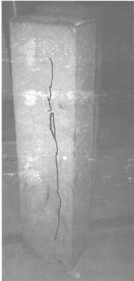
รูปที่ 12 การวิบัติของเสาคอนกรีตไม่มีเหล็กปลอกและรับแรงตรงศูนย์
