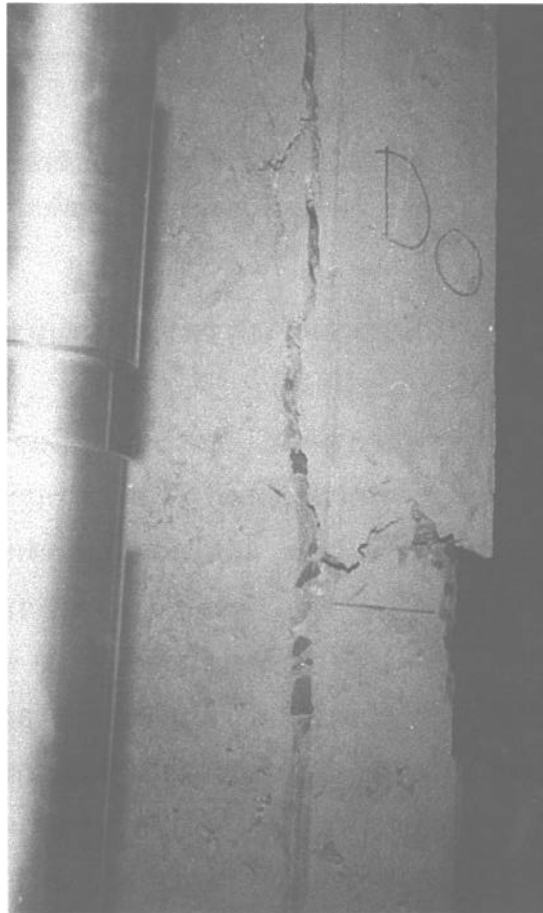
รูปที่ 13 การวิบัติของเสาคอนกรีตที่เสริมเหล็กที่มีเหล็กปลอกระยะห่างเท่ากับ 20 ซม. รับแรงตรงศูนย์
