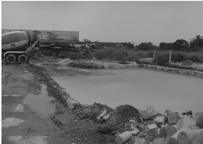
รูปที่ 1 ลักษณะทั่วไปของบ่อคายากากคอนกรีตของโรงงานคอนกรีตผสมเสร็จ
