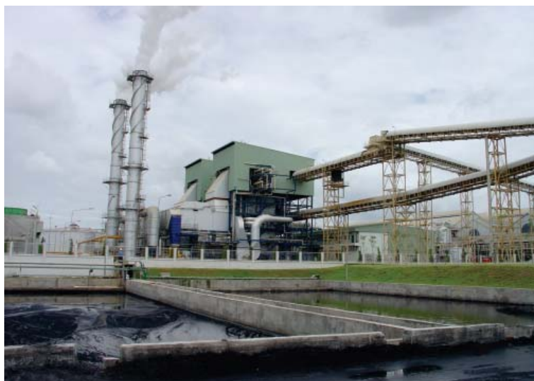
รูปที่ 1 เถ้าชานอ้อยบริเวณบ่อพักในโรงไฟฟ้าพลังงานชีวมวล
