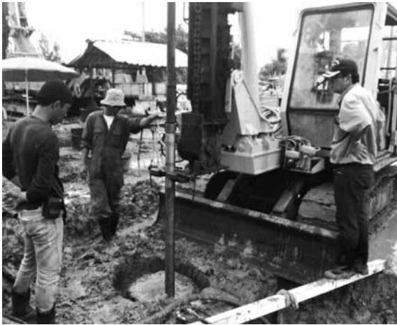
รูปที่ 4 การเจาะเก็บตัวอย่าง
