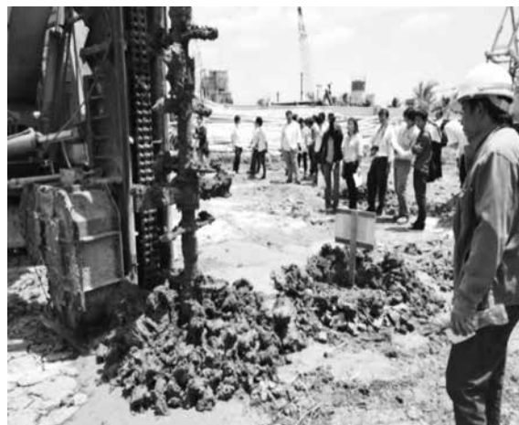
รูปที่ 2 การเจาะทำเสาเข็มดินซีเมนต์
