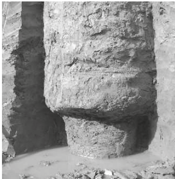
รูปที่ 2 เสาเข็มดินซีเมนต์รูปตัวที [8]
