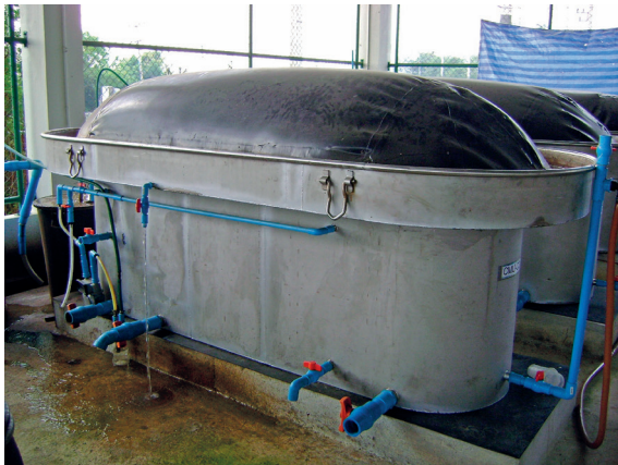
รูปที่ 1 ถังปฏิกรณ์ก๊าซชีวภาพแบบบ่อหมักทรง CMU-CD ขนาด 1,100 ลิตร [8]
