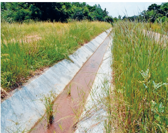
รูปที่ 17 ภาพถ่ายคลองชลประทานที่ได้รับการซ่อมแซมหลังจากผ่านการใช้งาน 6 เดือน
