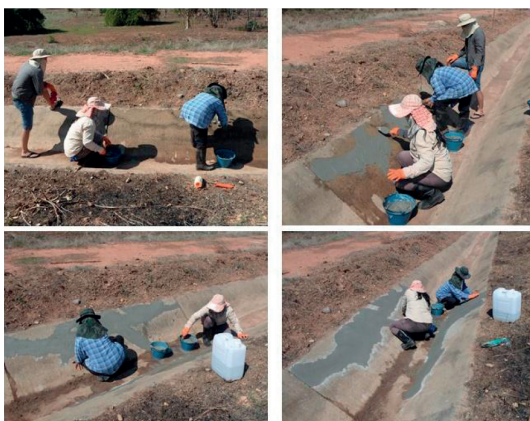
รูปที่ 14 เกษตรกรซ่อมแซมรอยแตกร้าวในคลองชลประทาน
