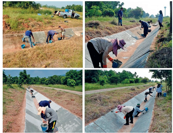
รูปที่ 15 เกษตรกรเคลือบผิวคลองส่งน้ำโดยใช้มอร์ตาร์ผสมน้ำยางพารา
