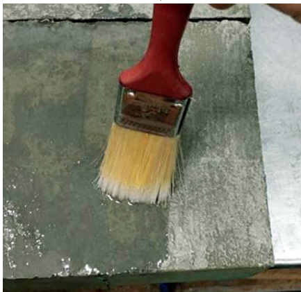
รูปที่ 1 การทาผิวหน้าคอนกรีตด้วยสารละลายโซเดียมซิลิเกต
