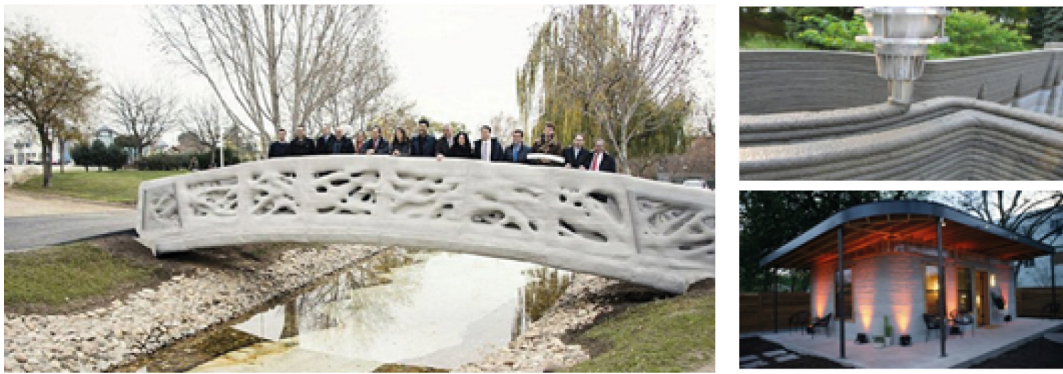
รูปที่ 15 สะพานคนเดินข้ามลำธารที่พิมพ์ด้วยการพิมพ์ 3 มิติ โดยใช้วัสดุพิมพ์ที่ใช้ในการก่อสร้างจริง (ภาพซ้าย) [36] และ หัวพิมพ์ขนาดใหญ่ (ภาพขวาบน) ส่วนภาพขวาล่างเป็นตัวอย่างบ้านพิมพ์ 3 มิติเช่นกัน ใช้เวลาในการสร้างเพียง 1 วันเท่านั้น (ไม่รวมการตกแต่ง) [35]
