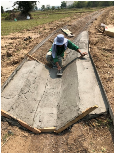
รูปที่ 15 ตาดผนังคูโดยใช้มอร์ตาร์ผสมน้ำยารพาราลงบนผนังที่ละด้าน
