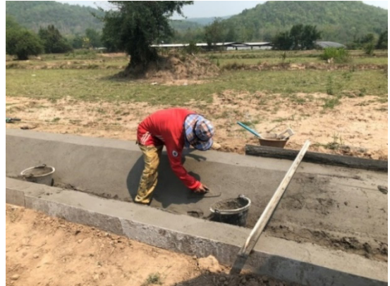
รูปที่ 16 การแต่งผิวผนังคูส่งน้ำแบบขัดหยาบ
