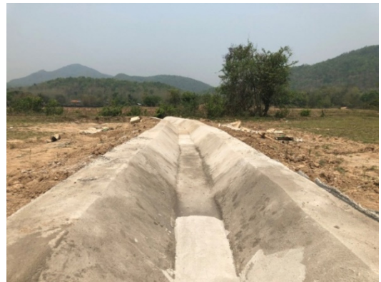
รูปที่ 17 คูส่งน้ำเฟอร์โรซีเมนต์แบบตาดในที่
