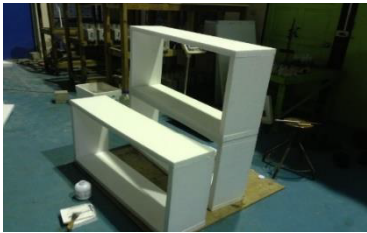
ก) ติดตั้งแผ่นโฟม
